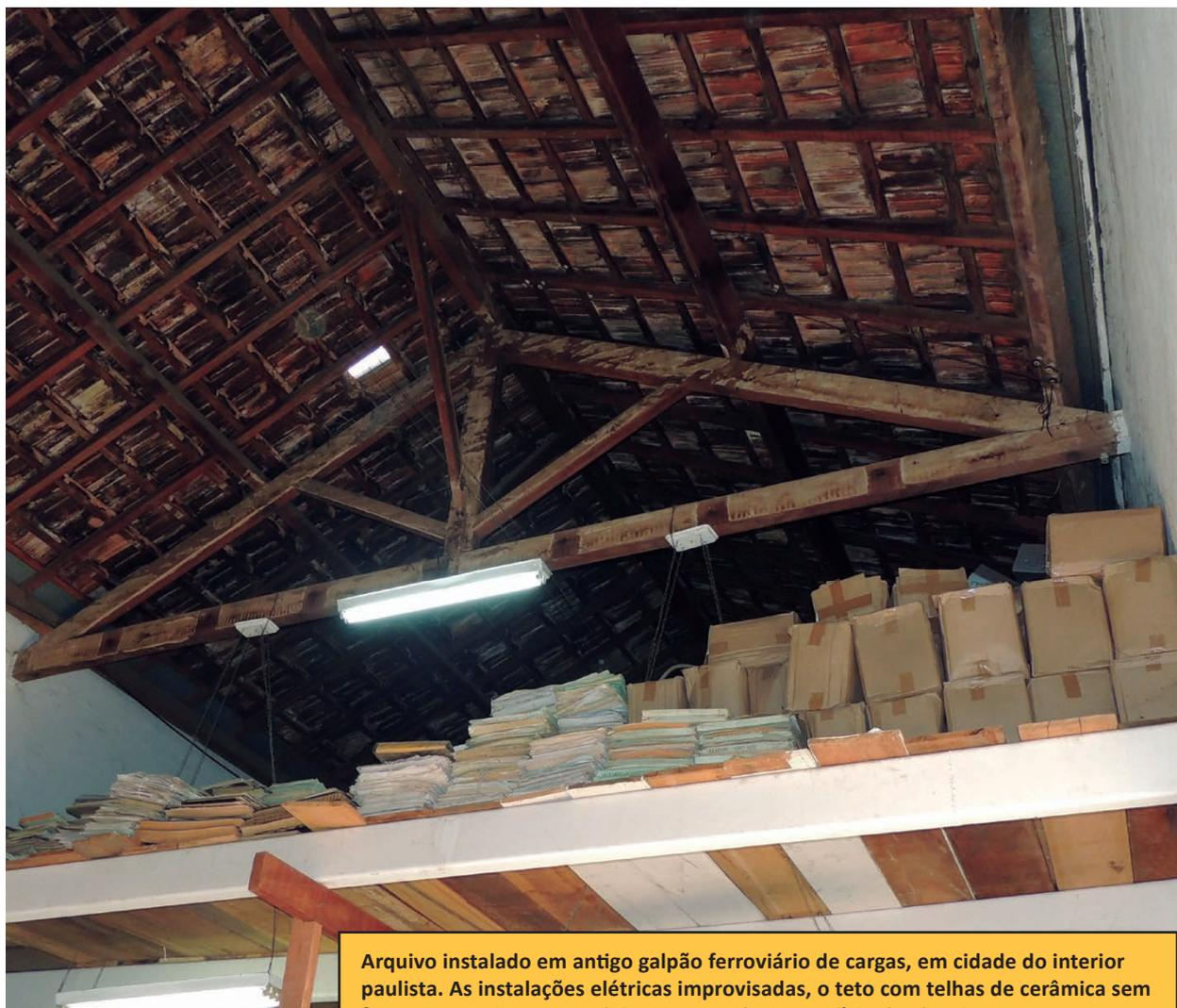
Arquivo instalado em antigo galpão ferroviário de cargas, em cidade do interior paulista. As instalações elétricas improvisadas, o teto com telhas de cerâmica sem forro e mezanino em madeira, compondo um cenário de alto risco ao acervo, para pragas, umidade e maior probabilidade de incêndios, em imagem de 13/08/2014. Foto: Arquivo do APESP.
